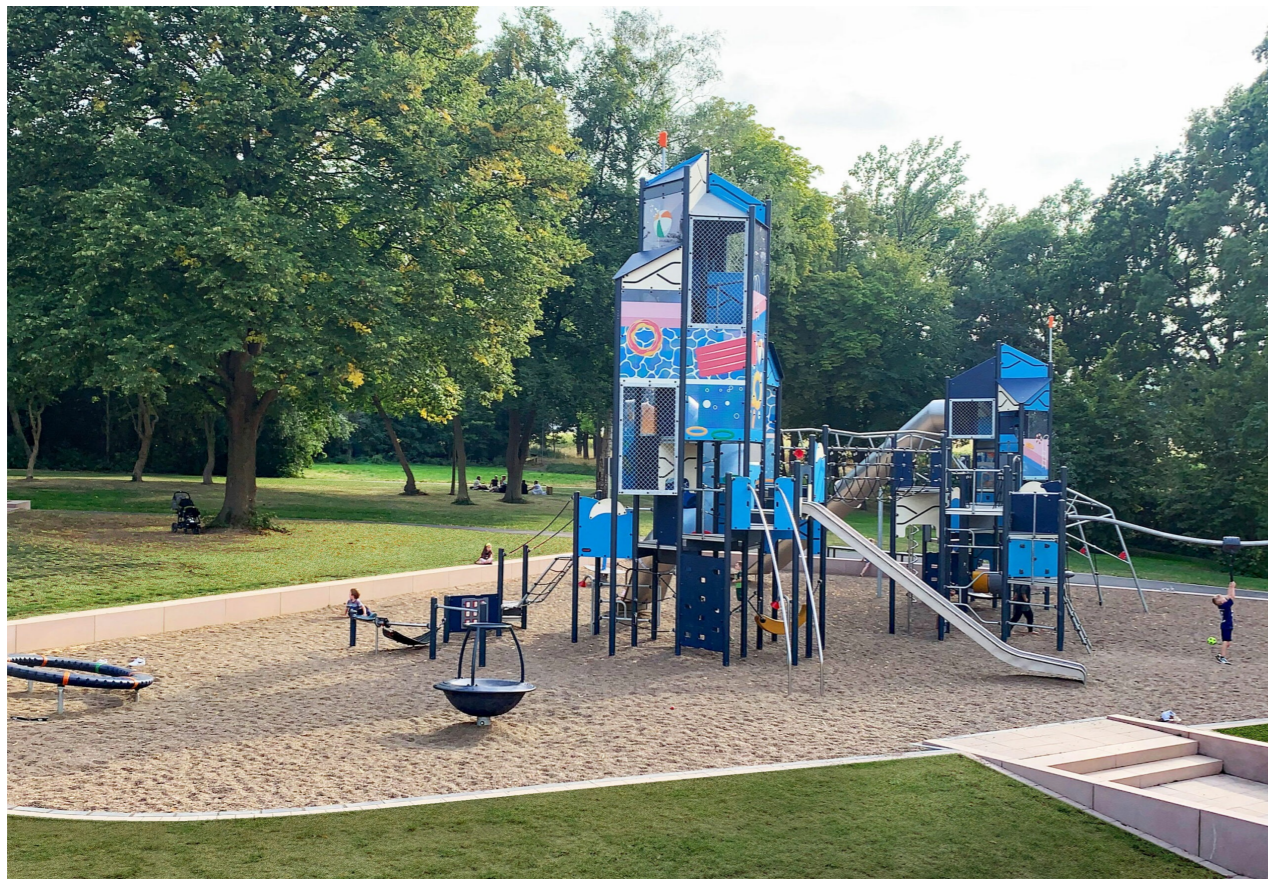
Blick auf den Spielplatz mit dem hohen Kletterturm Quelle: wbp Landschaftsarchitekten
