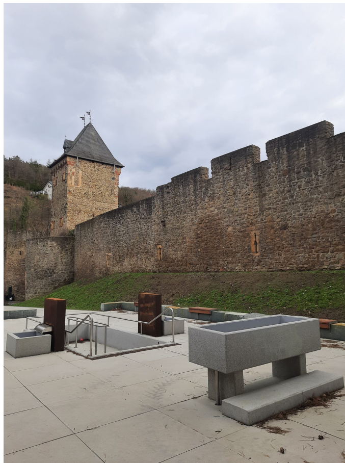
Kneipp-Tretbecken und Armbadeanlage
