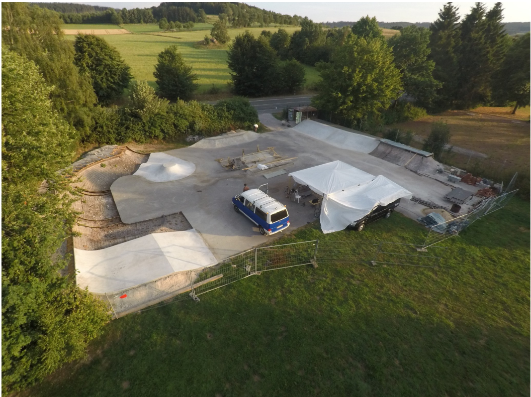
Luftaufnahme während des Umbaus Quelle: Rollverein Brilon
